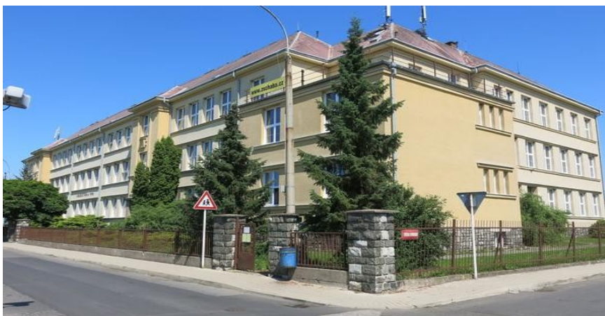
Obr.1 – ZŠ Chabařovice, hlavní budova
