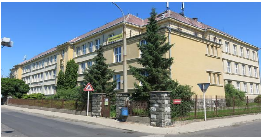
Obr.1 – ZŠ Chabařovice, hlavní budova
